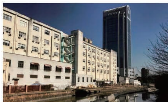
漕宝路440号租赁住宅项目：上海首个产业集团工业老厂房盘活转型租赁住房创新试点。
