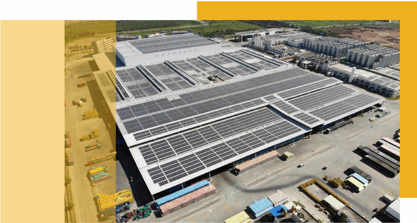
南沙公司光伏发电系统
