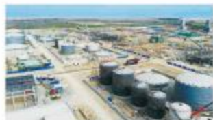
国庆期间,天业60万吨乙二醇项目建设繁忙
