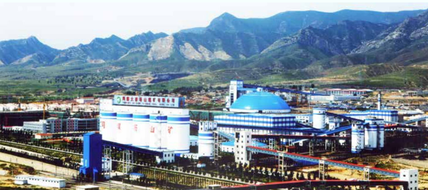
同煤塔山循环经济园区
