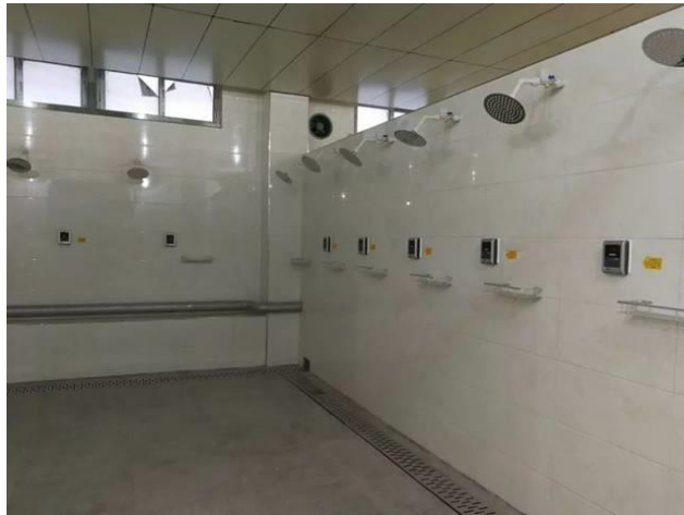
图注：鞍钢股份炼钢总厂修缮职工浴室
