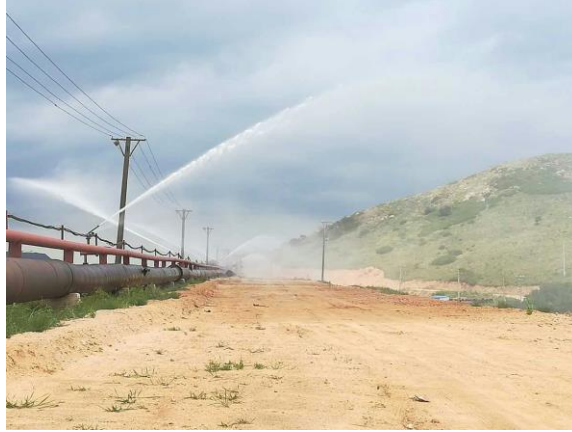
图注：鞍钢矿业公司进行喷淋抑尘
