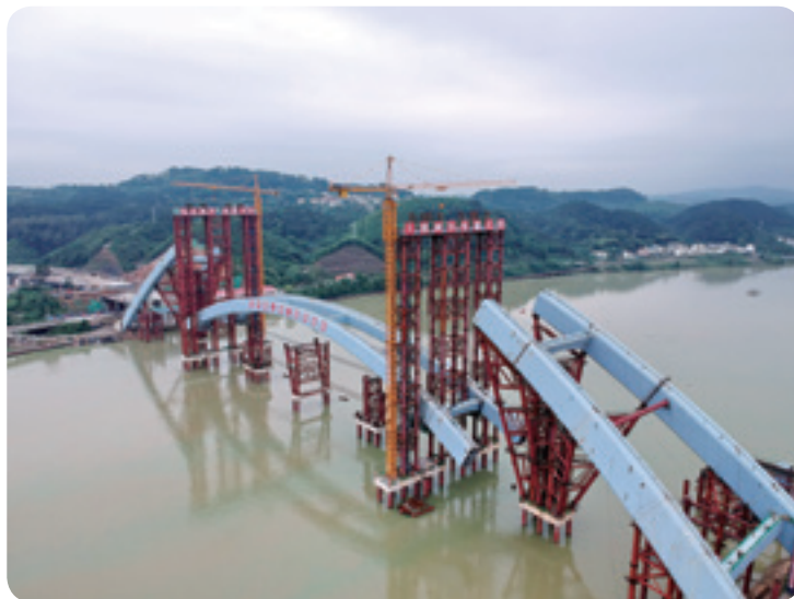
助力世界第一大推力钢箱梁拱桥——柳州官塘大桥建设
