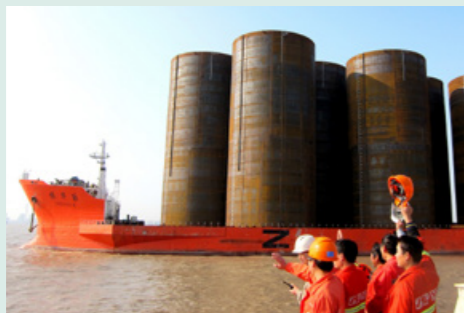
港珠澳大桥钢圆筒自振华重工长兴分公司码头发运。
