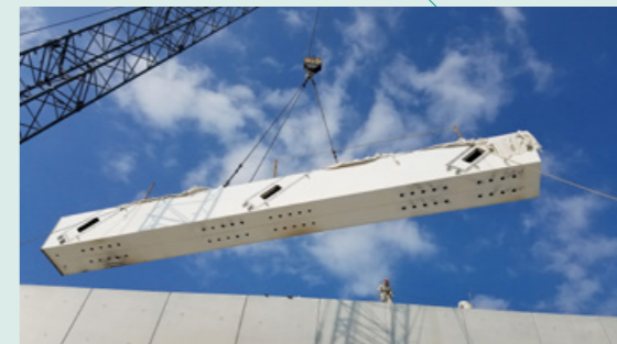
减光罩正在吊装。
