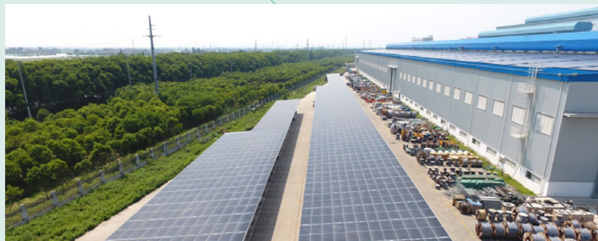
振华重工光伏车棚项目。
