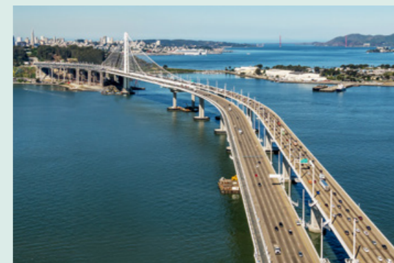
由振华重工提供全部钢结构的美国旧金山 - 奥克兰海湾大桥。
