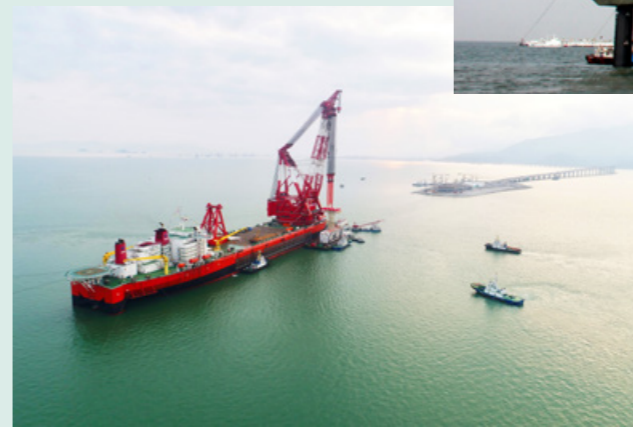
12000吨起重船“振华30”轮正在进行最终接头吊装。
