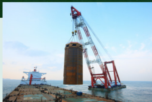
振华重工起重船“振浮8”正在进行钢圆筒吊装施工。
