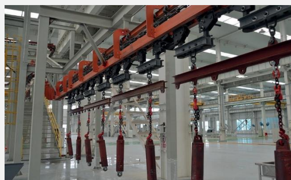
智能工厂里的立柱，千斤顶自动涂装生产线
