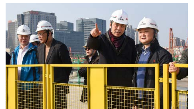
16 建工集团党委副书记、总裁卞家骏 检查徐汇滨江城开中心项目
