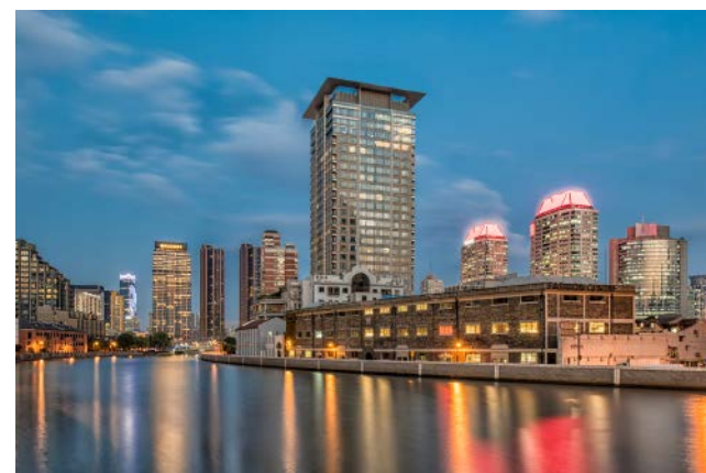
▼ 衍庆里修缮项目
