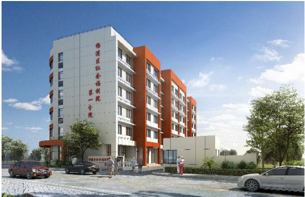
杨浦区社会福利院第一分院 (怀德路失能失智照护中心)
