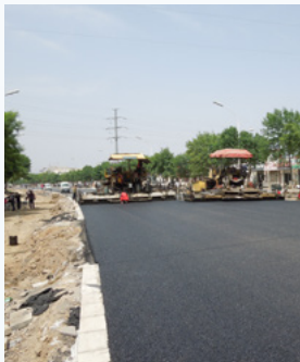
◆ 温拌路面摊铺现场
