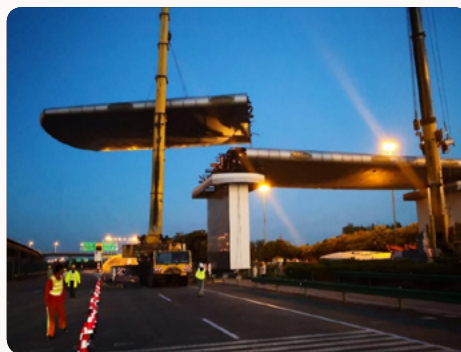
◆ 浦东国际机场遗留收费口拆除工程现场
