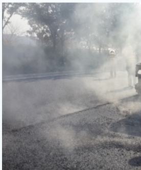
◆ 热拌路面摊铺现场
