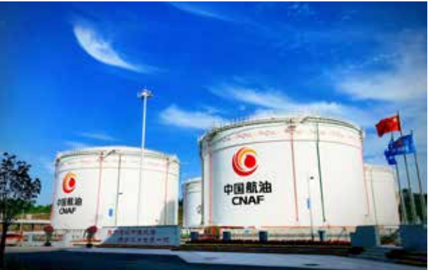
成都天府国际机场供油工程机场油库
