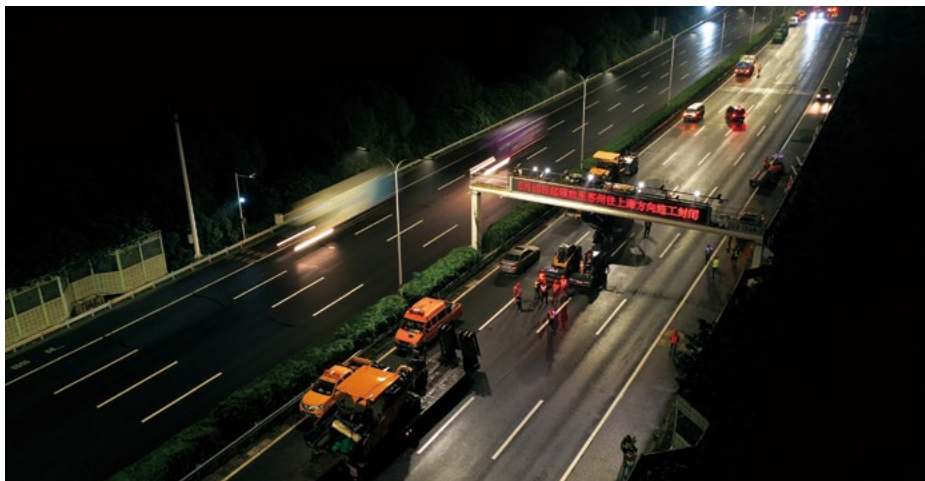
▲ “2.0” 超大流量高速公路集中养护样板——沪宁高速苏州段超大流量集中养护工程
