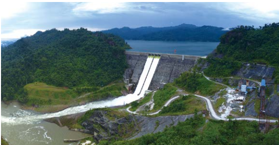
◆ 马来西亚沐若水电站项目
