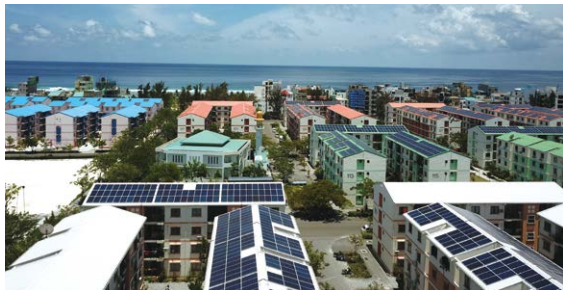
◆ 马尔代夫 1.5 兆瓦光伏电站项目
