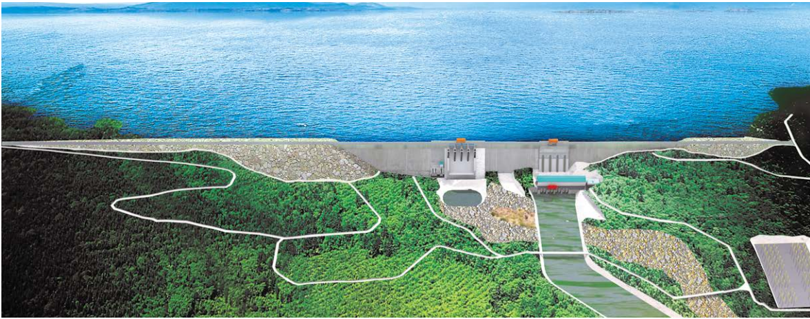
◆ 尼日利亚宗格鲁 700 兆瓦水电站项目
