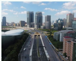
杨高路(世纪大道 - 浦建路)改 建工程荣获上海市建设工程绿 色施工样板工地
