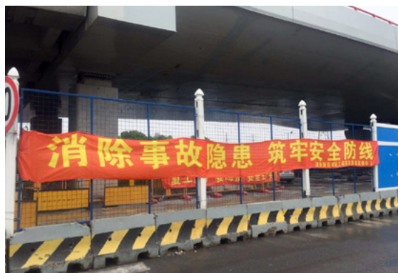
在建项目工地安全生产宣传
