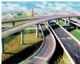
远东大道—迎宾大道立交工程 荣获中国建设工程鲁班奖
