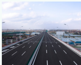
机场北通道排水降噪沥青路面
