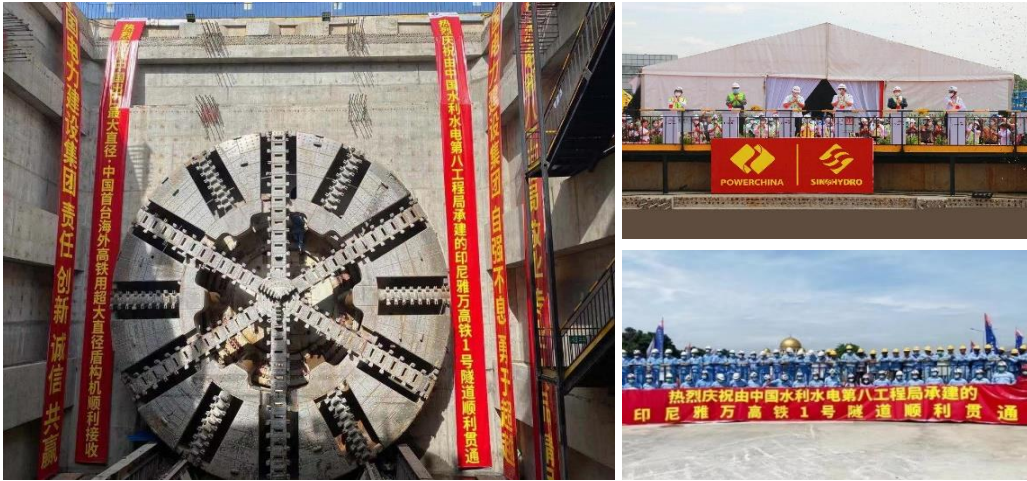
印尼雅万高铁1号隧道盾构贯通现场
