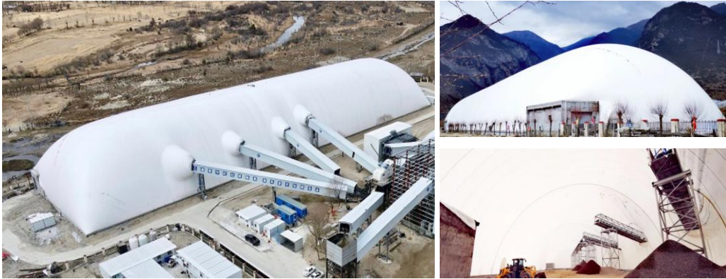
川藏铁路尼洋河砂石加工场全线达标投产
