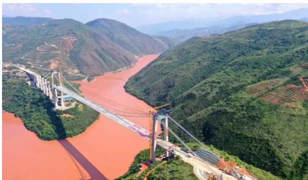
2020年9月5日，红河特大桥主跨成功合龙
