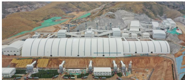
建设中的河北南水北调雄安调蓄库弃渣综合利用工程工地现场
