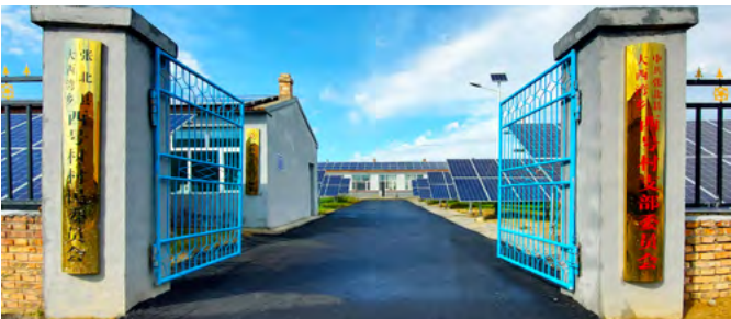
张北县西号村分布式光伏发电项目
