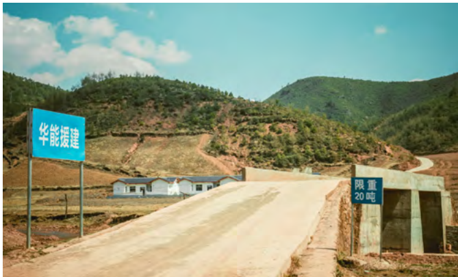
四川省昭觉县团结村安全行桥
