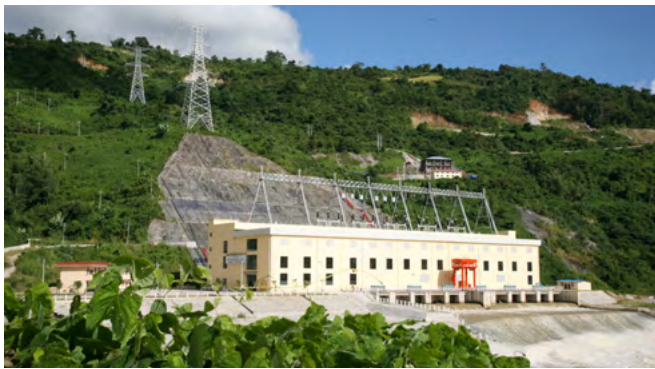
缅甸瑞丽江一级水电站
