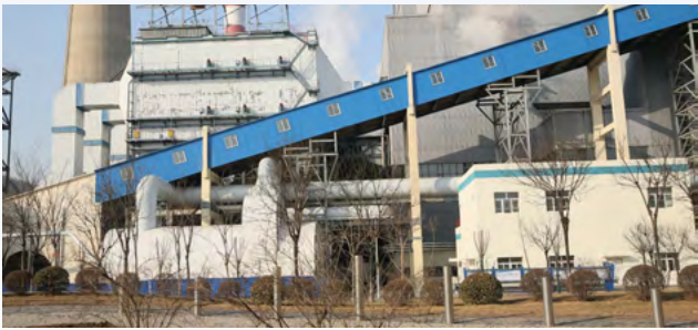
杨柳青热电污泥发电项目
