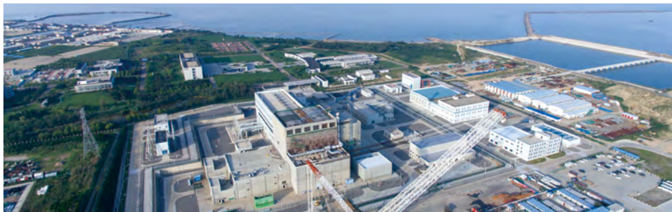
石岛湾高温气冷堆示范工程
