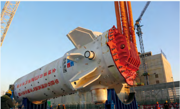
首台蒸汽发生器吊装就位
