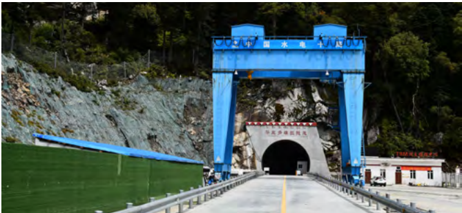
多雄拉隧道入口
