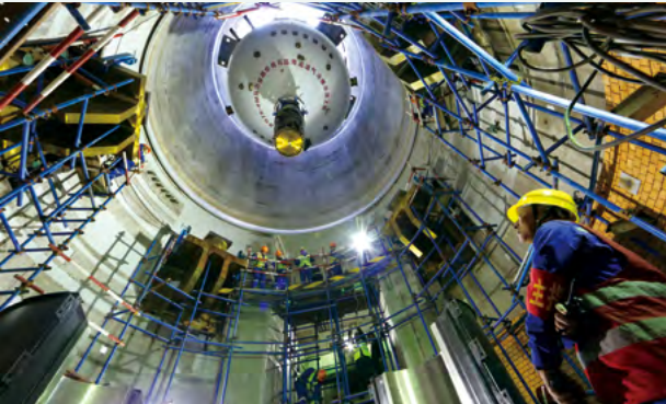
首台反应堆压力容器吊装就位
