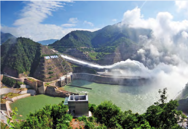
糯扎渡水电站
