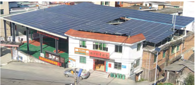
湖河村 185 千瓦光伏发电项目
