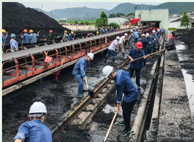
井冈山电厂对煤场进行清理加固
