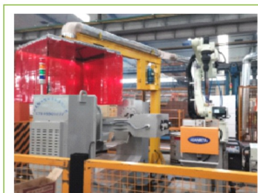
无锡柳工偏心轴焊接机器人手烟尘治理
