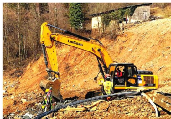
柳工设备参与格鲁吉亚E60高速公路项目
