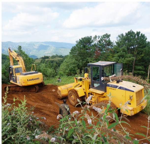
柳工挖掘机在帮扶地区修筑“致富”路
