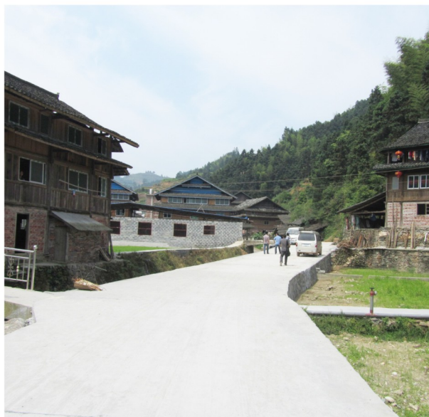
柳工修建的硬化路
