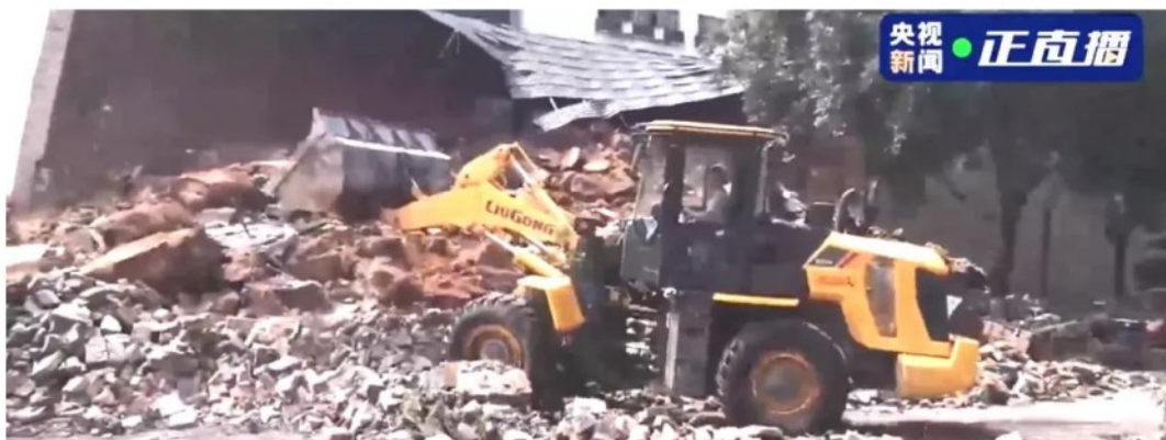
正在进行道路清理的柳工835H装载机
