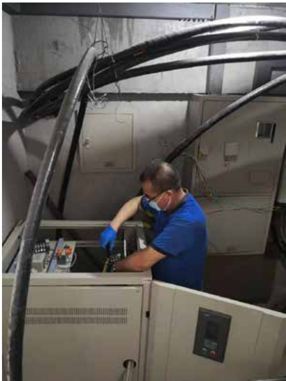
← 图二：公司工程师为终端客户检修并调试稳压器
