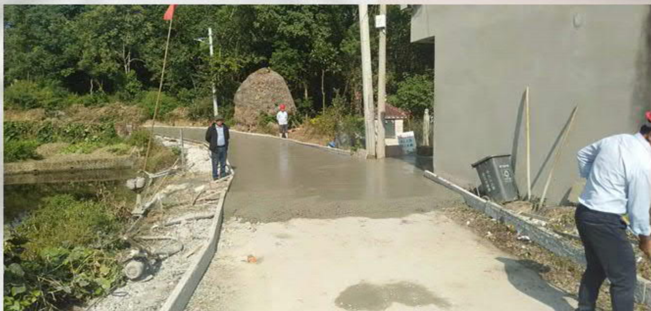
高士镇通组道路修葺
