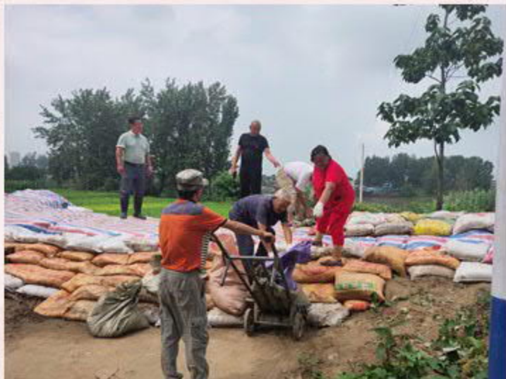
防汛加固堤坝
