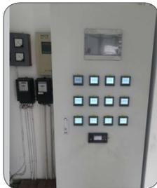
2020年6月，企业投资38.3万元实施冷冻空调动力集中监控系统。通过改造提高设备自动化程度和信息化水平，消除因人员配备不足可能会产生的安全隐患。
