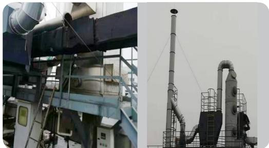
2020年10月，企业投资30万元改造污水站，污水池加盖和增加臭气处理设备，减少污水池的臭气排放。
