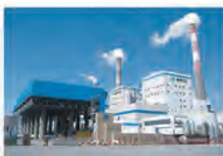
燃煤电站节能及超低排放
