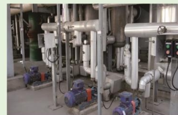
氢气回收装置
