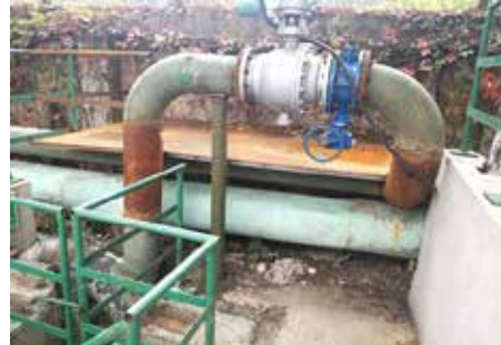
张家港联合铜业在雨水总排口处设置电动球阀和手动蝶阀
