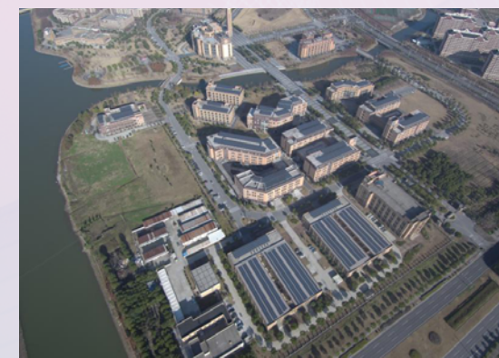
上海电机学院光伏项目
