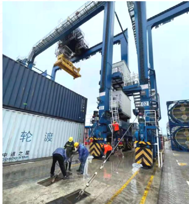
浙江台州大麦屿项目 正在部署防台措施
