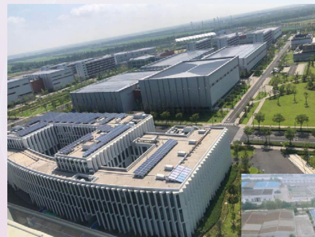
上海体育职业学院光伏项目
