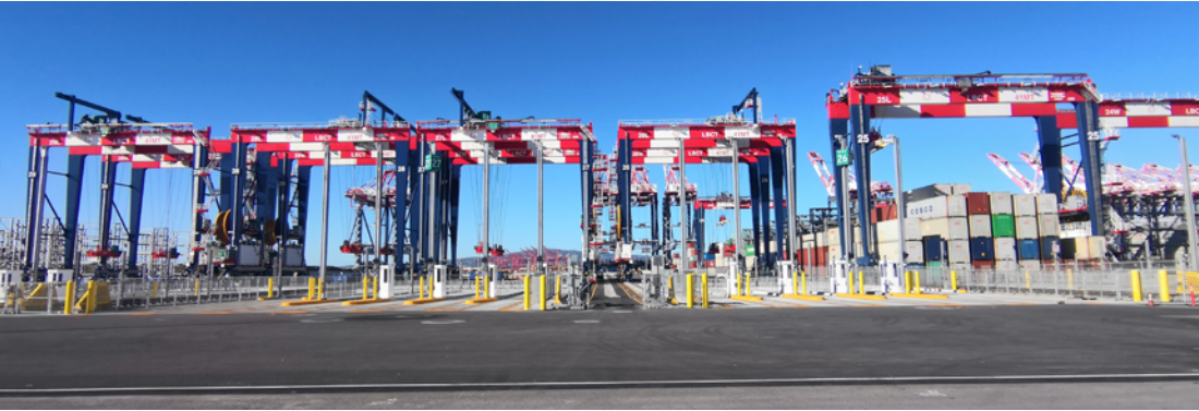
振华重工为长滩港建造的全自动轨道吊
