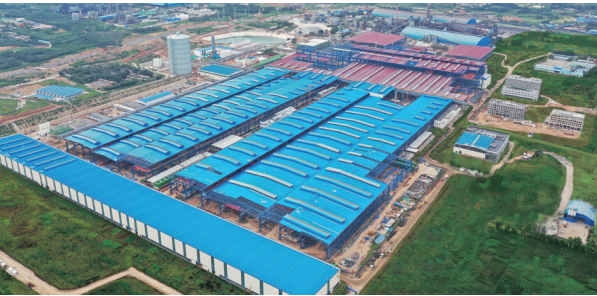
河钢石钢绿色厂区
