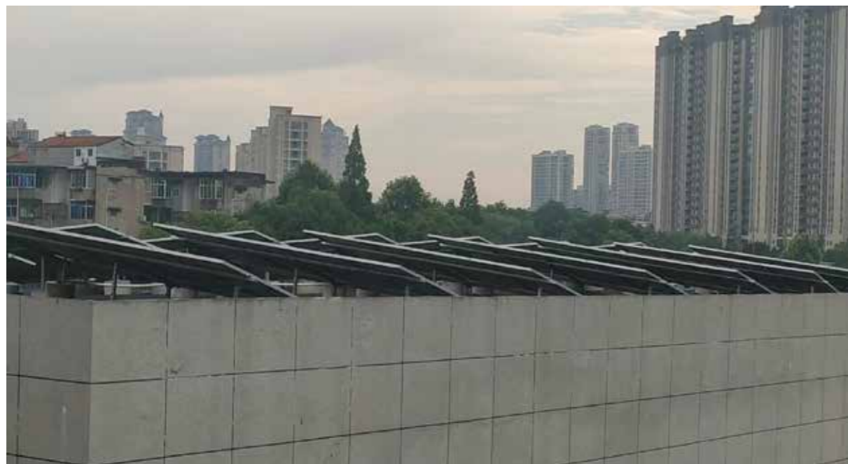
图为凤登公司新建屋顶光伏设备
