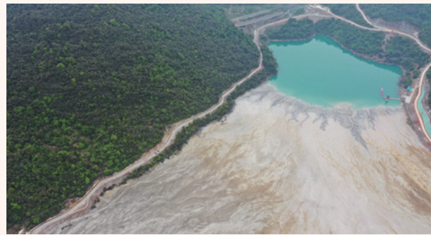
中色大冶丰山铜矿尾矿库截洪沟
