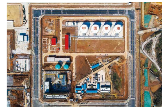
鄂州民用机场供油工程现场直播
