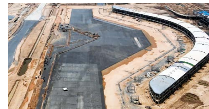
机坪管线施工状态
