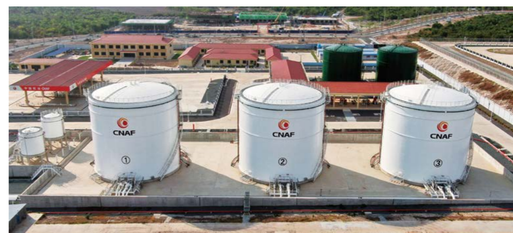
2022年11月30日，暹粒吴哥国际机场供油工程项目顺利通过竣工验收
