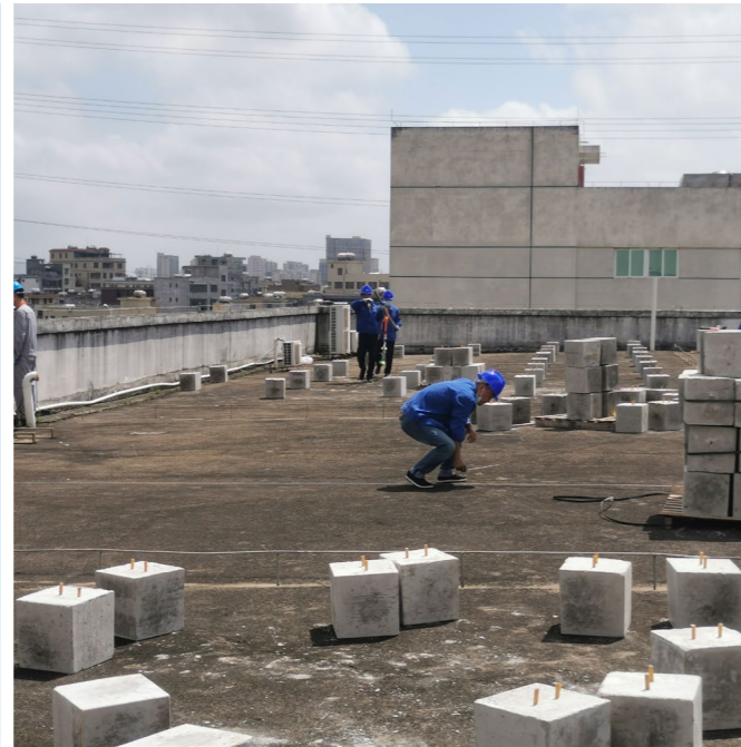
^ 施工人员测量放线
