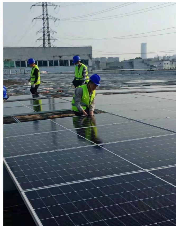
v 施工人员安装光伏板
