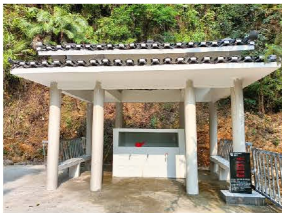
帮扶思欧村修建蓄水池配套设施
