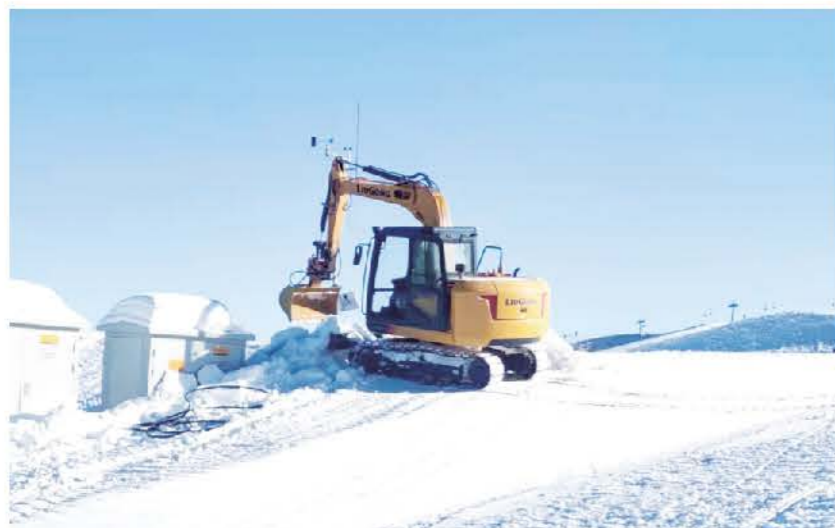
柳工9075E挖掘机正在冬奥会赛场上作业
