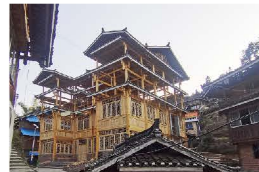
柳工援建高友村集体食堂综合楼项目
