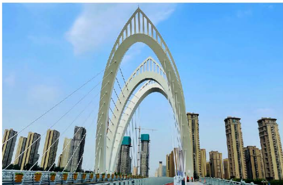
国内首座碳纤维索公路斜拉桥——兴华路跨徒骇河大桥
