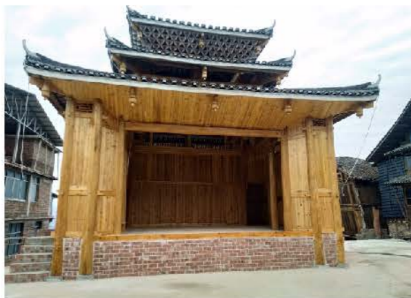
帮扶枫木村修建文化综合楼
