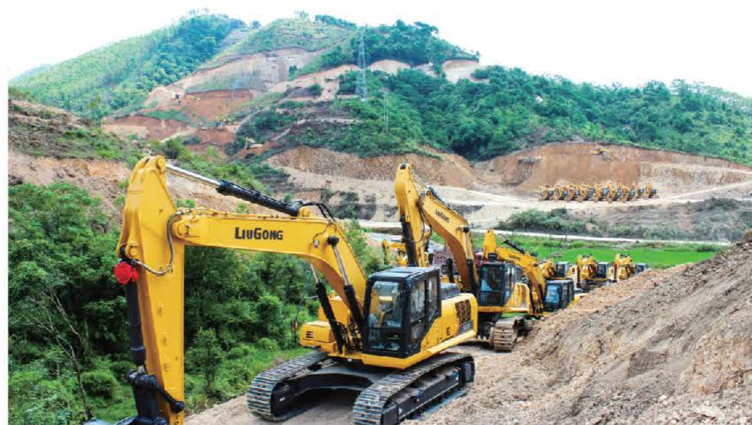
柳工挖掘机批量集结平陆运河项目现场，助力项目顺利建设
