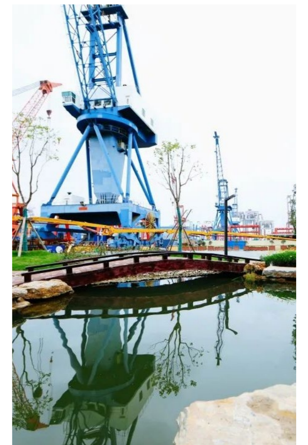
初期雨水收集治理处理系统及景观池
