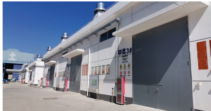
新建危废仓库
