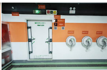
钢筋混凝土密闭门
