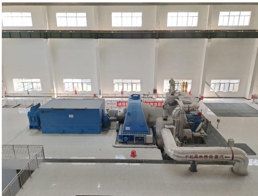
中天绿色精品钢项目机组现场照片
