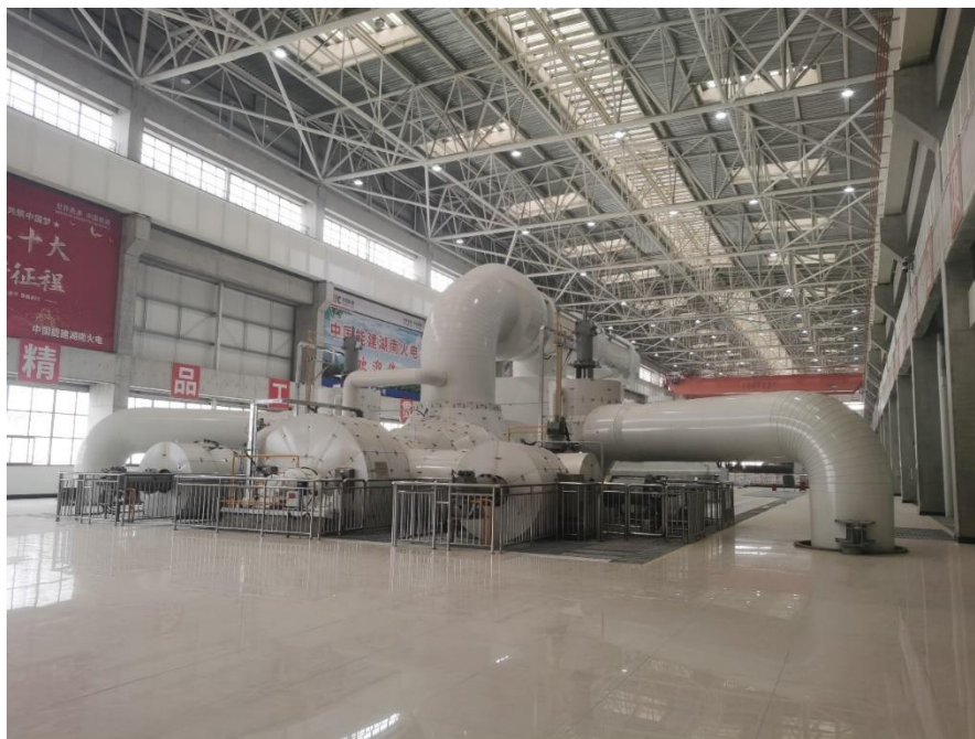
湖南华电平江一期 2*1000MW 煤电项目 1 号机组
