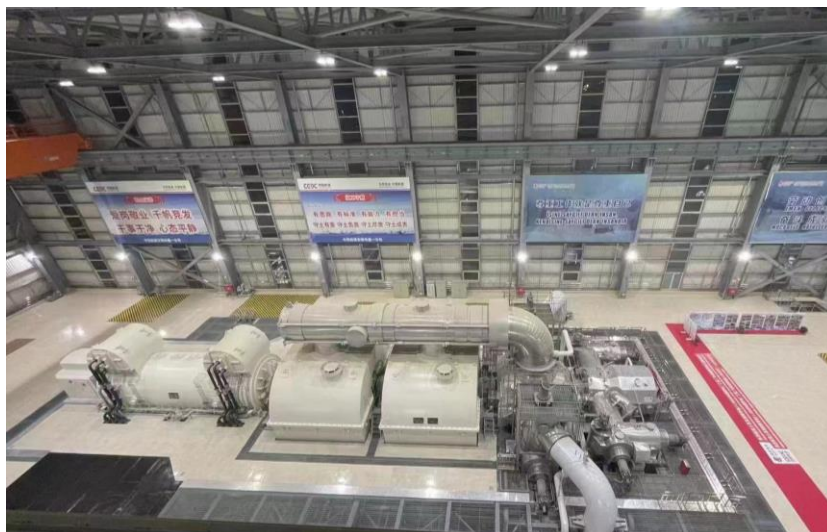
土耳其胡努特鲁项目 660MW 等级四缸四排汽汽轮机
