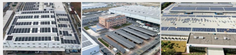
广汽部件园区光伏项目建设
