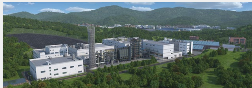
广州市废弃物安全处置中心
