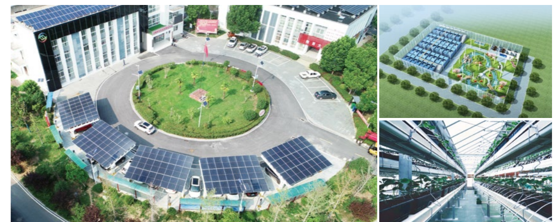
▲ 长丰能源综合改革创新试点陶西新村屋顶光伏项目 (光伏幕墙 + 光伏车棚 + 风光储一体路灯)
