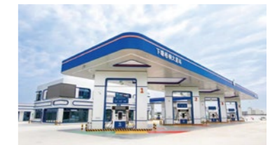
皖能下塘综合能源港（梧桐大道站）
