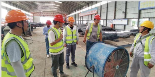
钢筋加工场设备、临时用电检查
