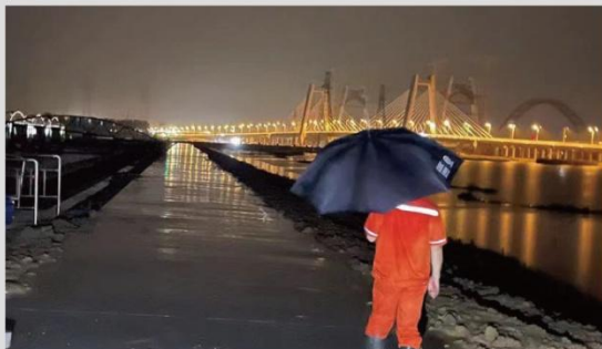
夜间防洪防汛水位隐患巡查
