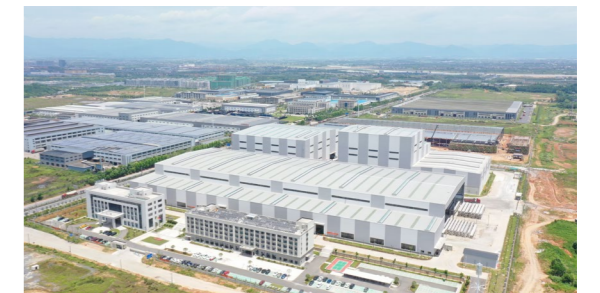
浙江交工衢州建筑工业化基地
