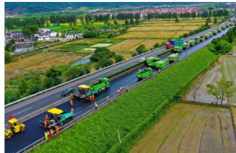
台金高速集约化养护施工
