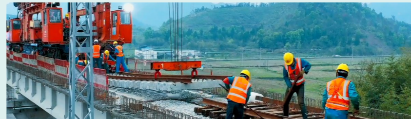
浙江交工工程施工
