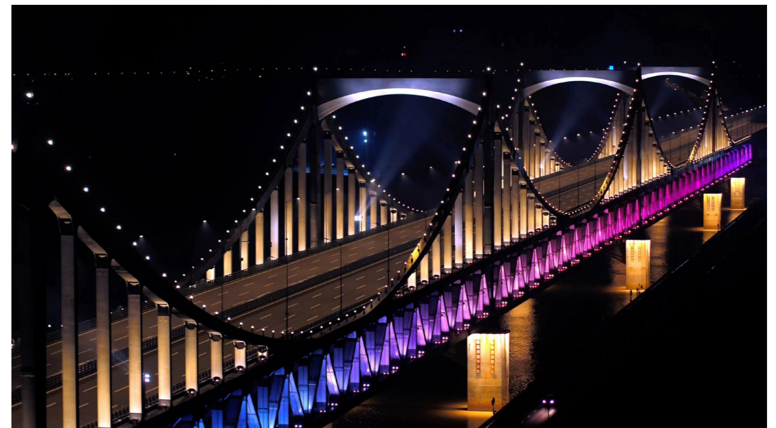
浙江交工承建亚运重要交通保障项目彭埠大桥
