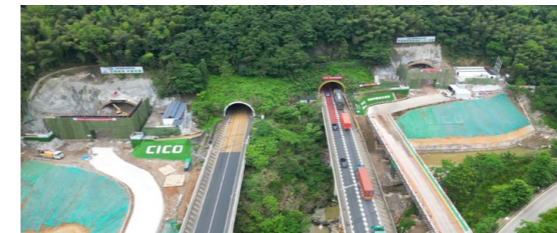
猫狸岭隧道施工现场
