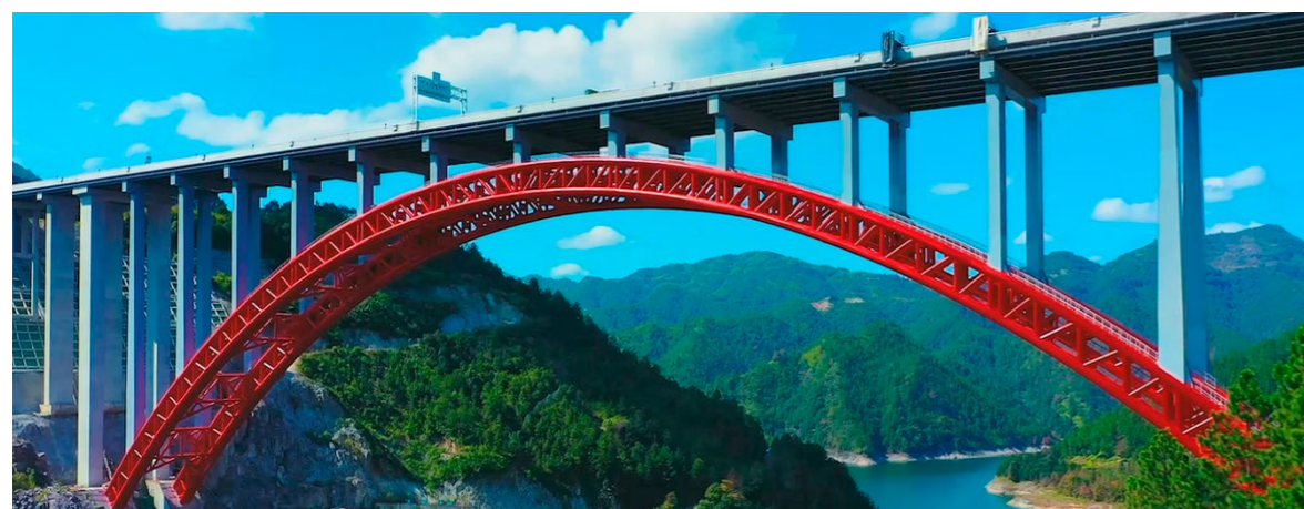
文泰高速洪溪特大桥
