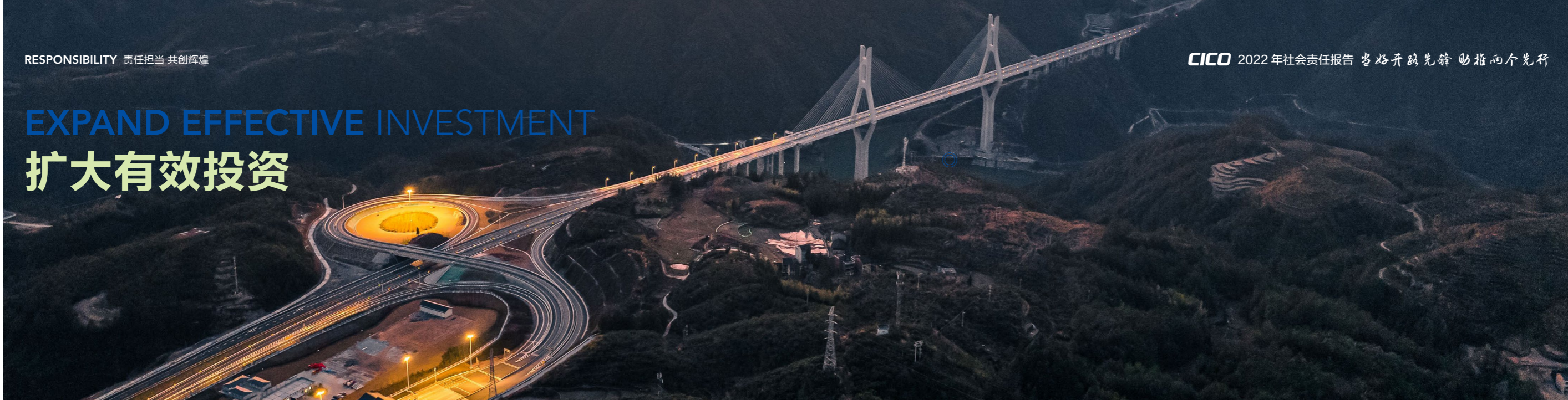
景文高速高岭头水库特大桥
