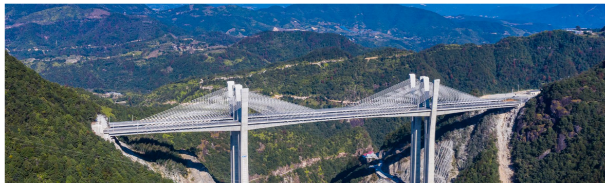
浙江省文成至泰顺（浙闽界）公路工程荣获 2022 年“钱江杯”优质工程奖
