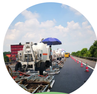
沥青就地热再生路面施工
